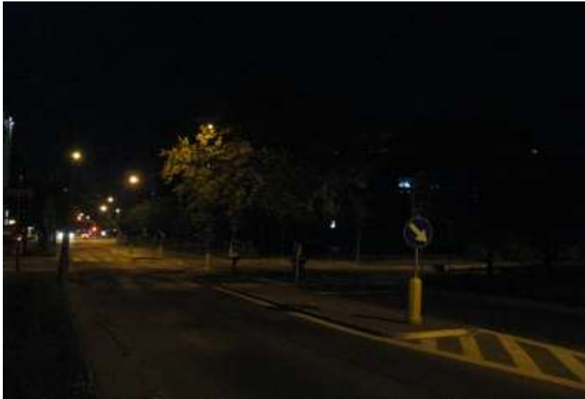
Oświetlenie przejścia - brak
