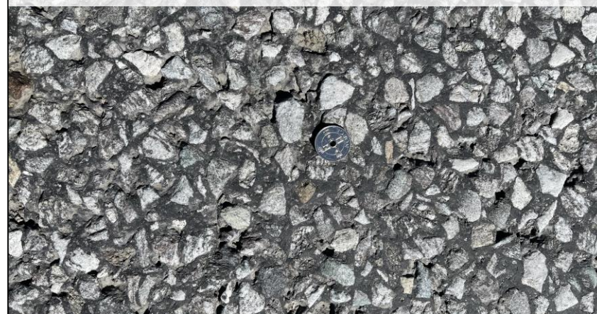
Sørumsund (Norwegia) Nawierzchnia SMA16
