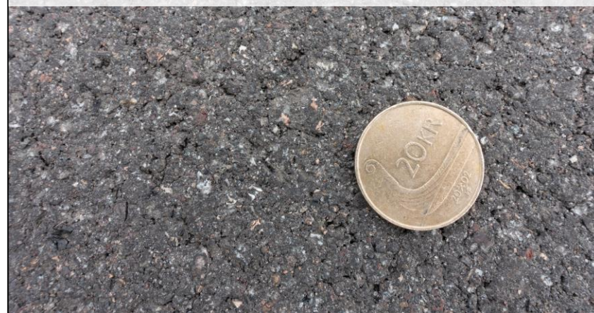
Sørumsund (Norwegia) Nawierzchnia SMA16
