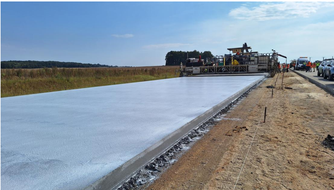
Układanie nawierzchni betonowej na odcinku między Bobrownikami a Skórowem
