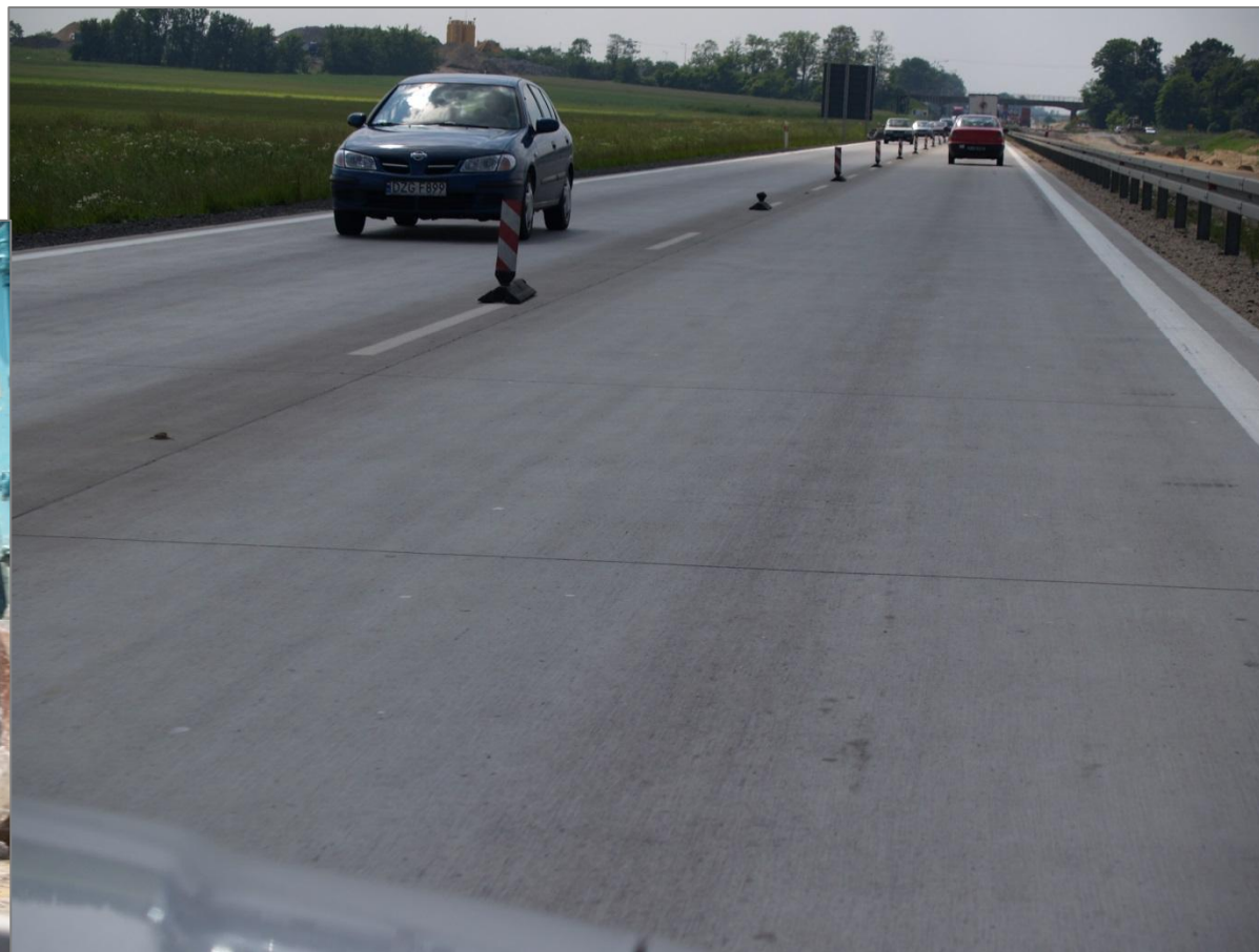
Budowa A4 Wrocław-Legnica 2004
