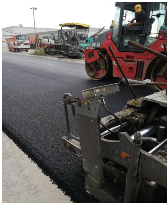
Rys. 14. Wbudowanie AC 16W z 40% DA w warstwę konstrukcyjną
