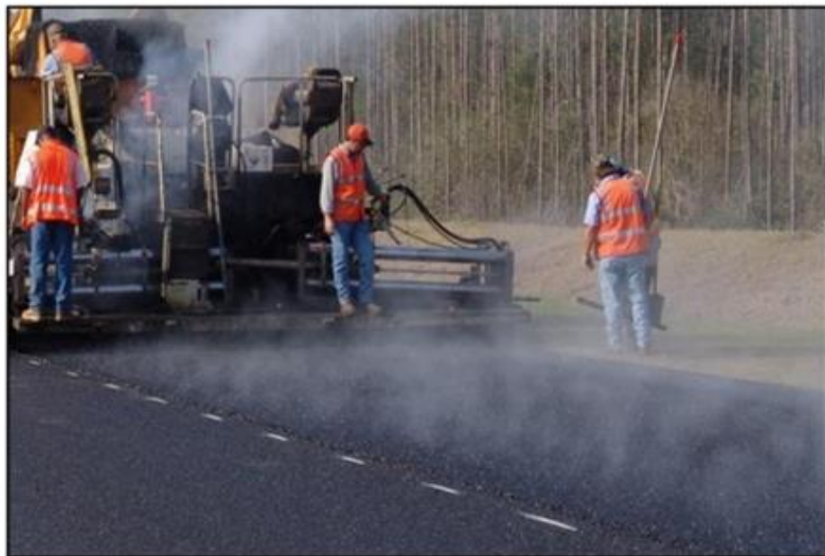
Rys.2. Efekt oddziaływania wysokiej temperatury podczas wykonywania nawierzchni*
