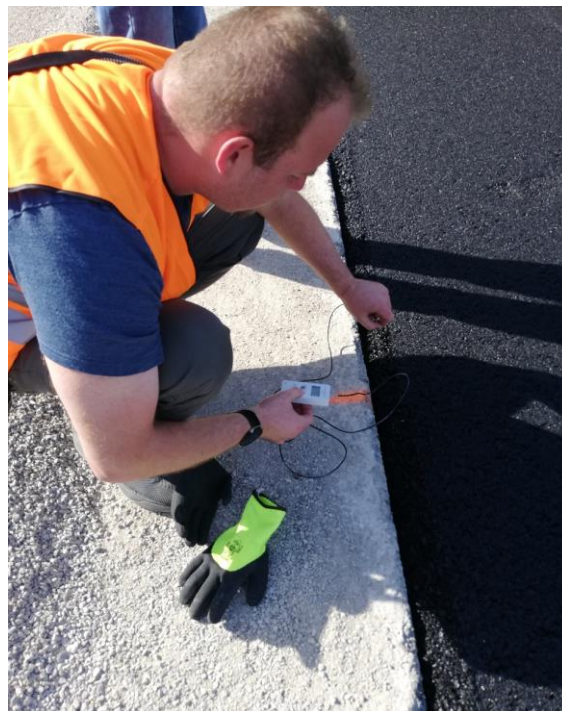
Rys. 15. Pomiar temperatury zagęszczania 100°C
